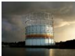
Gasbeholder på Sundby Gasværk, København S (1960'erne)
