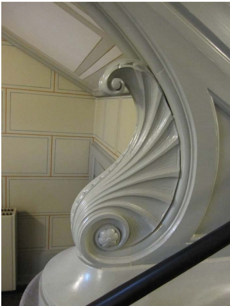
Botanisk Laboratorium, København, udsækering ved vestibule
