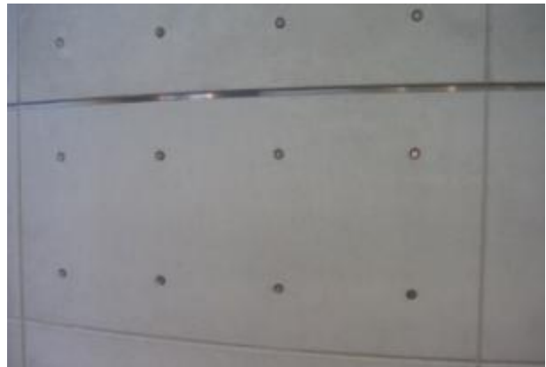
Detalje med opdeling af betondelene.
