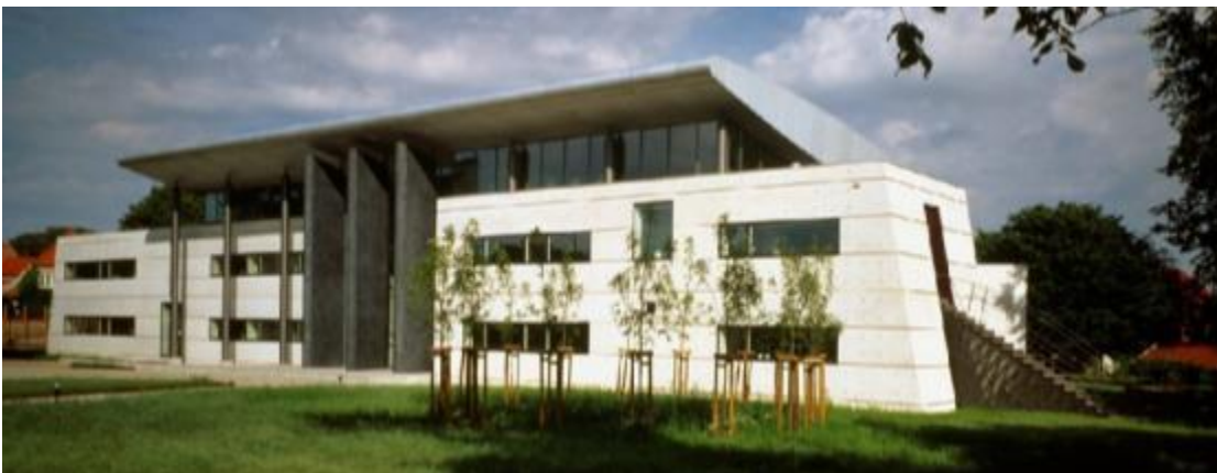
Facaden mod Skivevej. Her ses de to kontorbokse, alle ni søjler og det flyvingeformede tag. (foto 3xN)
