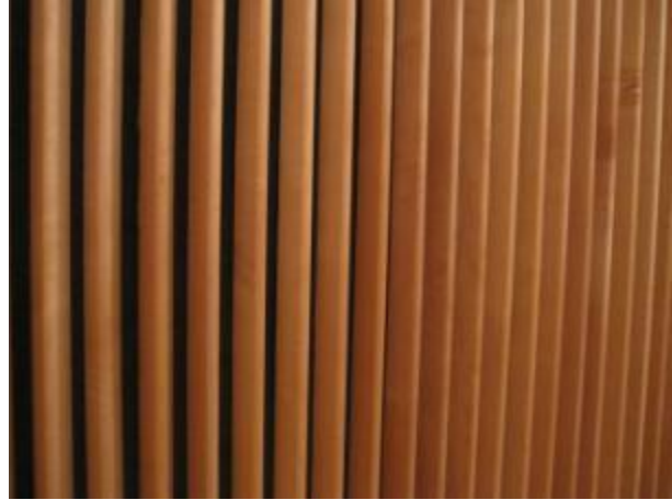
Akustikpanelerne på den buede væg.
