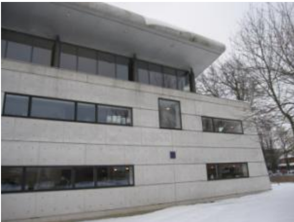
Den sydligste kontorboks.
