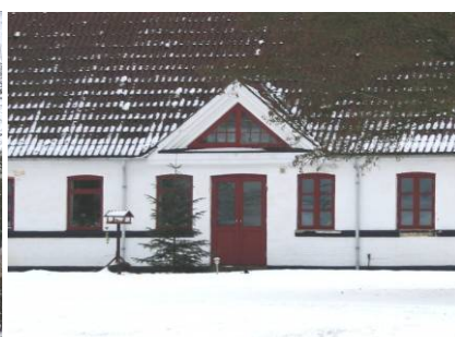
Stuehus til gård i Eskør.
