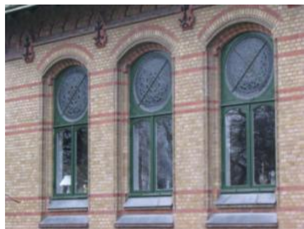
Mosaikvinduer set udefra. Læg mærke til vindjernerne.
