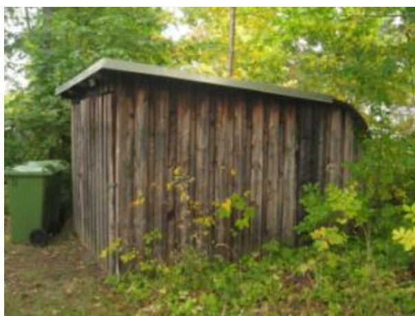
Skur tæt ved Jægersborgs Allé
