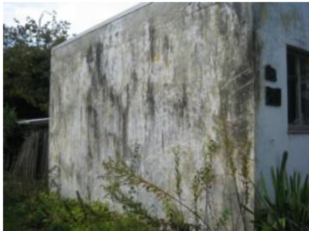
Mur på sydboksen
