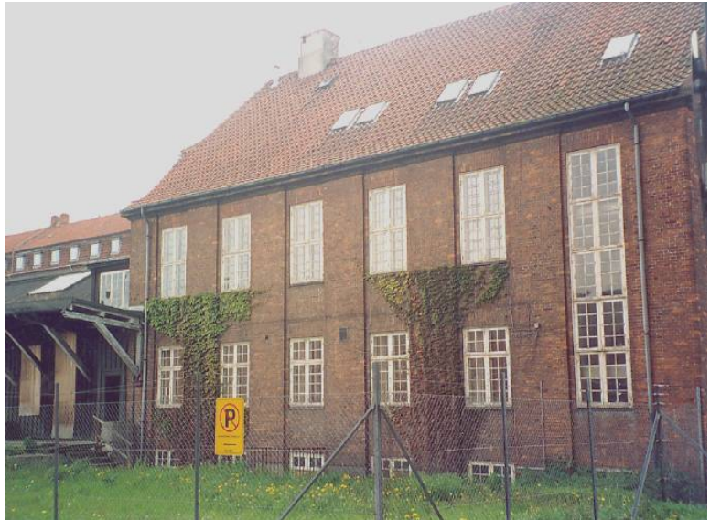
Godsfragtstationen, set fra Føtex' P-plads. Det delvist murede trappetårn ses over hallens udhæng, lige til venstre for stationsbygningen.
