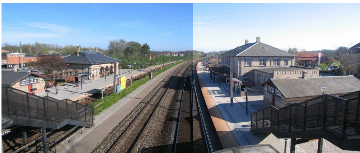
Rungsted Station i dag, det 4. spor er sløjfet og erstattet af en perron. Hovedbygningen har fået en lav tilbygning og forsynet med baldakiner mod perronen. Desuden er en der gangbro som forbindelse mellem perronerne.
