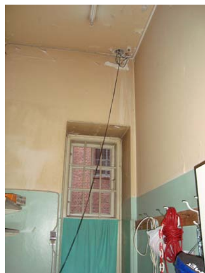
Kig ind i depotrum i dameafd. i mellembygningen. Loftet ej sænket.
