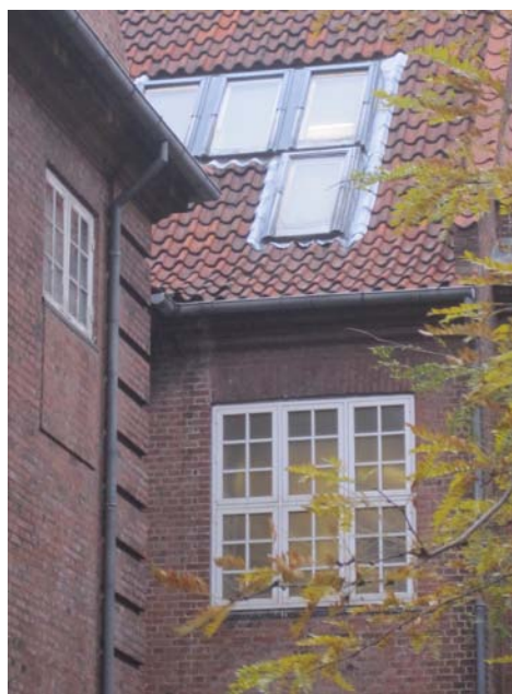
Tværbygningens facade mod gården. I facaden nyere vindue af plastic i ”gammel stil”.
