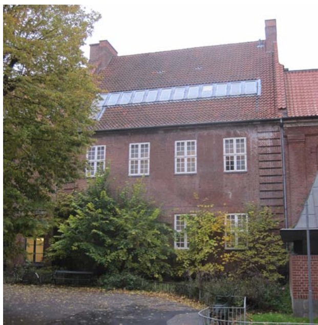
Tværbygningens bagside med tagvinduer fra 1960'erne. T.h. anes kirkebygning m. moderne tilbygning.
