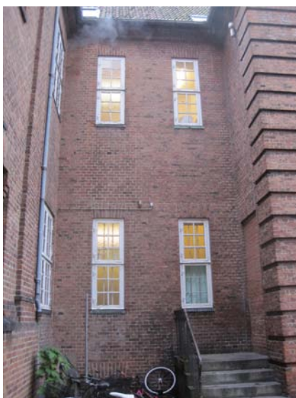
Mellembygning set fra gade.
