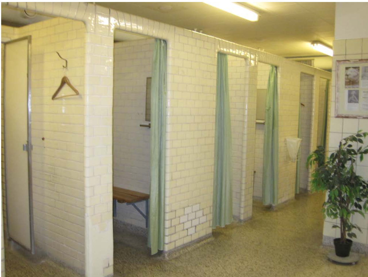
Damernes brusebadsafdeling i tværbygningen; originalt gulv og flisebeklædning.
