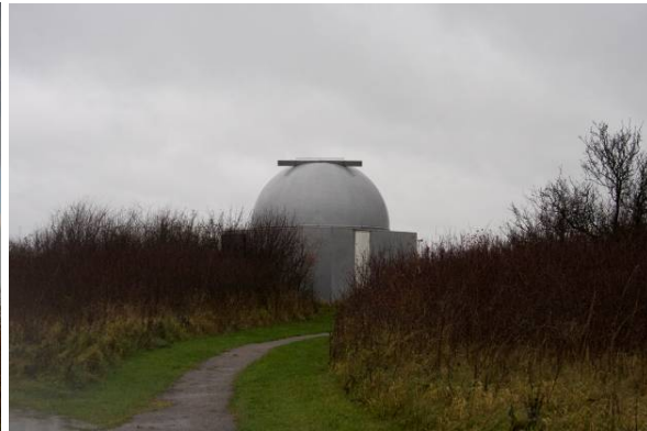
En smal stil gennem buskene fører op til bygningen
