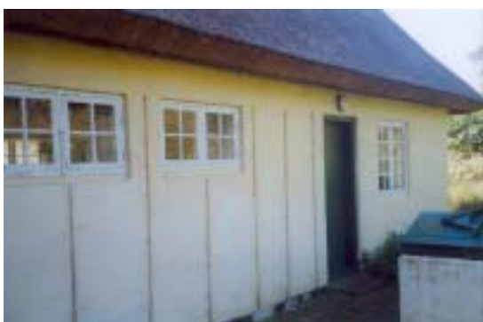
Bakkedalen 11: tegnet af Mogens Clemmensen, opført 1917. Huset har været i samme families eje siden 1921, og udover det i 1961 indrettede bad i det sammenbyggede udhus og nye fløjdøre ud til loggiaen, er der ikke foretaget ændringer hverken ud - eller indvendigt siden opførelsen, og sommerhuset fremstår fuldstændig autentisk, med alt inventar og køkken bevaret til i dag.
