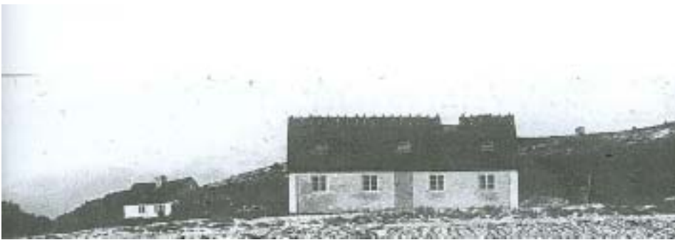
Klammerhøj 8 i forgrunden; nr. 10 er stadig forsynet med den oprindelige skorstenspipe
