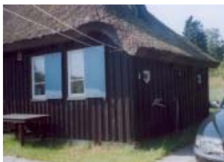
Nord - enden med køkken og bad
