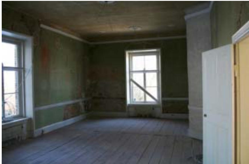
En væg er nedtaget imellem "det rosa hjørnekabinet" og dagligstuen mod nord.
