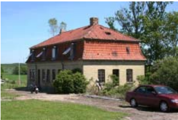
Forpagterboligen, nord for hovedbygningen
