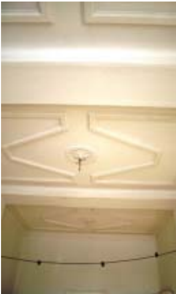
Kassetteloft i kabinettet
