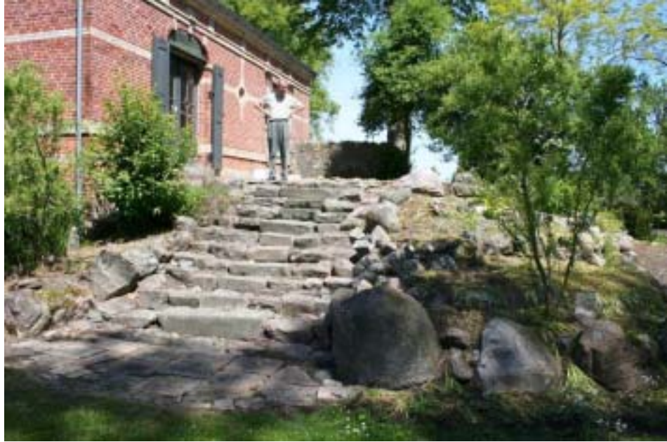
Stenhøjen med terrassen opad østgavlen.
