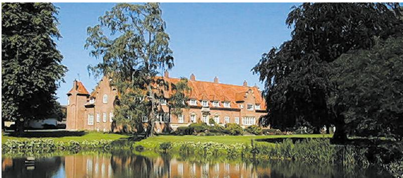
Hovedbygningen, set fra parken. Terrassen ses til højre for det gamle birketræ.
